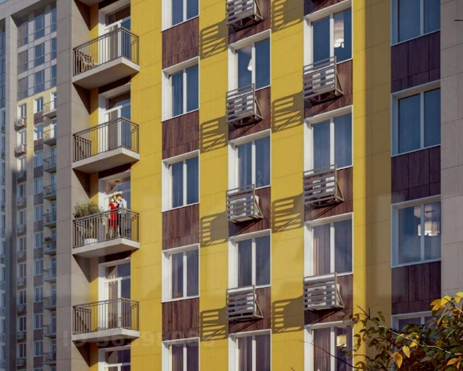
Корзины, экраны и панели для кондиционеров сохраняют индивидуальный облик здания после установки на него климатического оборудования любых размеров, придают зданию законченный внешний вид и украшают его фасад. Данное решение актуально для всех типов современных фасадов, так и для фасадов исторических зданий.
