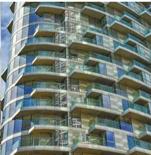
Im Osten Londons bietet der 45-stöckige Wohnkomplex Providence Tower einen spektakulären Blick über die City von London. Das mehrdimensionale Fassadenspiel aus Glas, Aluminium und Terrakotta mit auskragenden Balkonen wurde von der Lindner Fassaden GmbH umgesetzt. Bericht ab Seite 8
